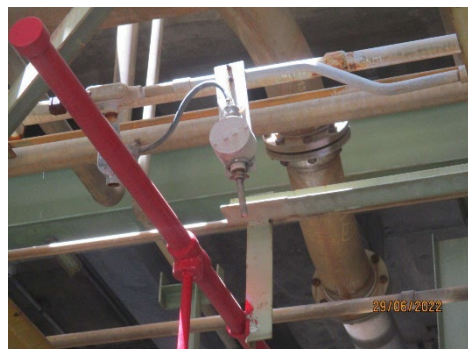
ภาพที่ 2-22 Heat Detector
