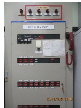
ภาพที่ 2-20 Gas Detector และแผงแสดงสัญญาณในห้องควบคุม
