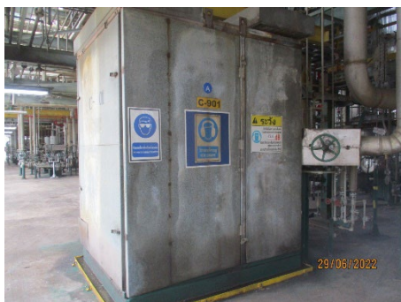
ภาพที่ 2-12 กล่องครอบบลดเสียงดังจากเครื่องจักร
