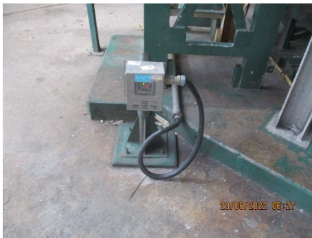
ภาพที่ 2-20 Gas Detector และแผงแสดงสัญญาณในห้องควบคุม
